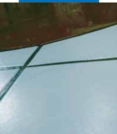
Particolare dell'applicazione di Ultraplan su pavimento in ceramica esistente previa applicazione di Eco Prim T Plus
