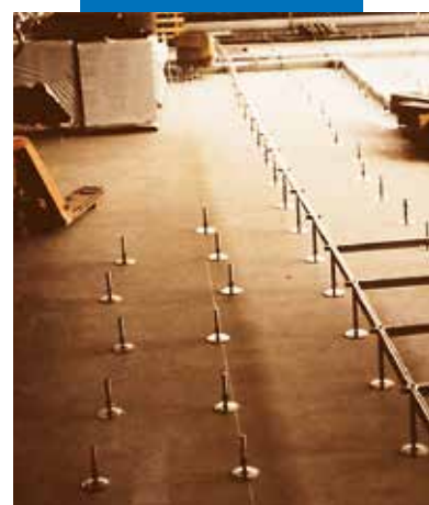
Soletta livellata con Ultraplan per messa in opera di pavimenti galleggianti
